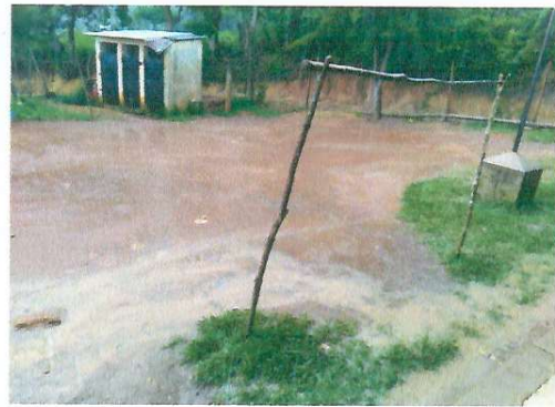
Foto 2: Loza de cemento al corredor de la cocina .Loza de cemento al patio de los módulos
