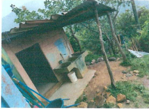
Foto 1: Mejoramiento de cocina, cambio de puerta de estructura de madera a metal, y cubierta de lámina troquelada calibre 26, cambio de pilares de estructura de madera a metal del corredor cubierta de lámina troquelada calibre 26
